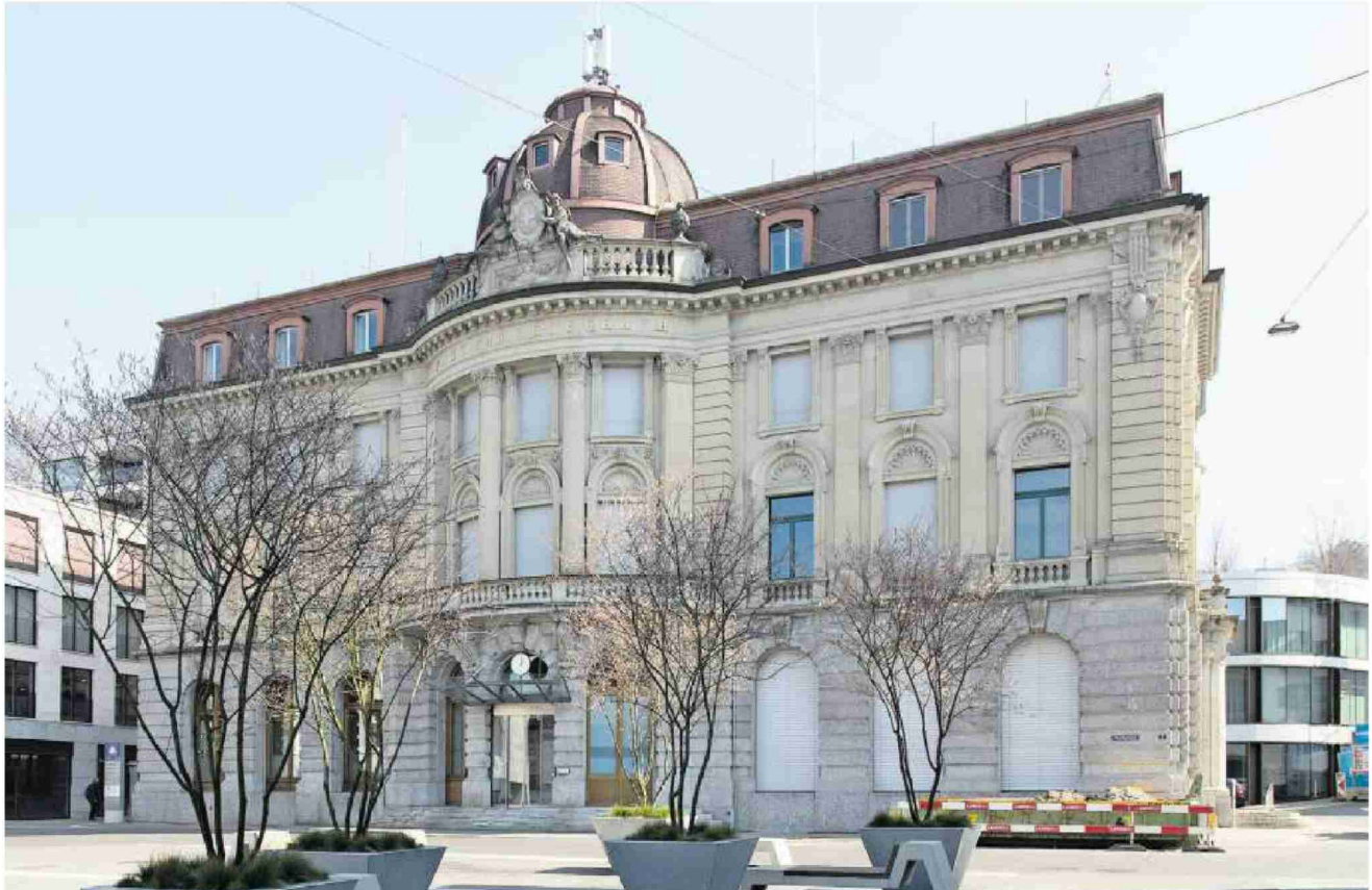
Werden bald Restaurantgäste den Postplatz beleben?
