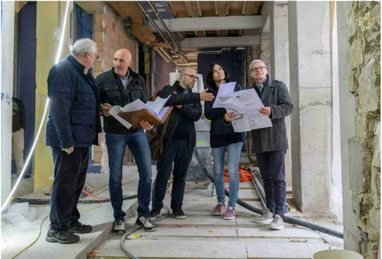
René Liechti, Pascal Burr, Ladislao Recupido, Irène Kessler und Manuel Bergamini (von links) diskutieren in einer Loggia den Baufortschritt.
