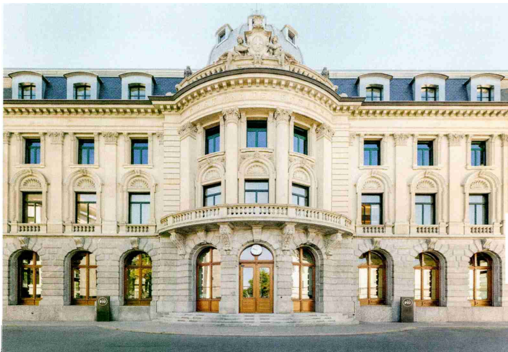
Neues Leben im historischen Zuger Postgebäude.
