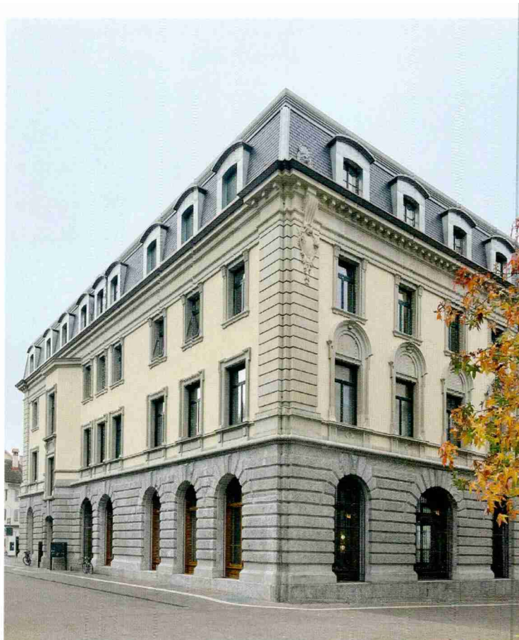
■ Aussen wurde die historische Sandsteinfassade umfassend saniert. Die Blechverkleidung der Lukarnen, Kuppel und Löwenköpfe werden mit der Zeit eine Patina ansetzen und nachdunkeln. (Bild: Post Immobilien AG)
