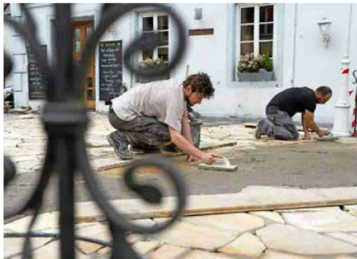
Endspurt: In Diessenhofen wird die Terrasse noch neu gepflastert.
